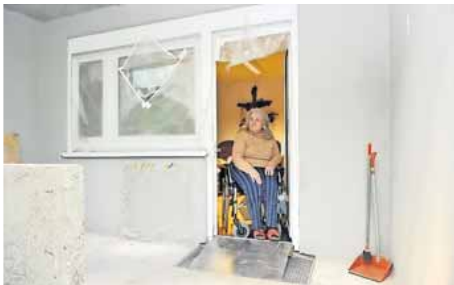
Ans Haus gebunden: Christel Festl, die auf den Rollstuhl angewiesen ist, kam wegen der Bauarbeiten zeitweise gar nicht mehr raus.
